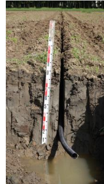
【カットドレーン(左図)を応用した本暗渠施工機化の試作機による施工状況(右図)】
